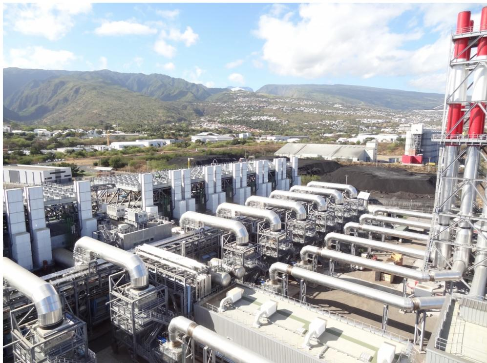
Vue des conduites de fumées incluant le réacteur SCR
